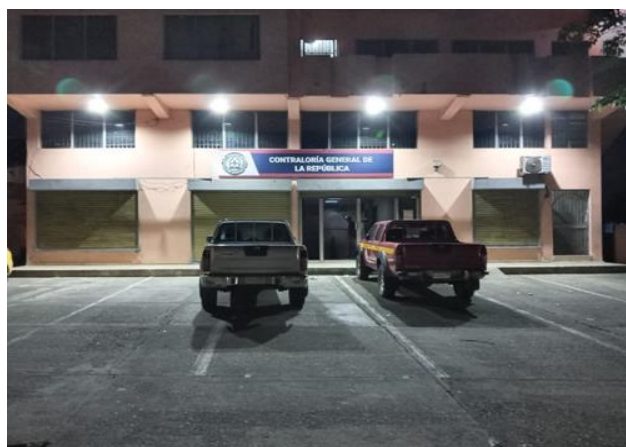
Iluminación Panamá Oeste - Después
