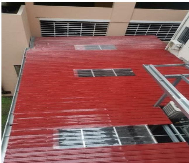
Foto: Suministro e instalación de techo en el nivel 100 del edificio anexo. Efectuado por la empresa Constructora Mercosur, S.A., a un costo de B/.15,500.00 Octubre de 2021.
