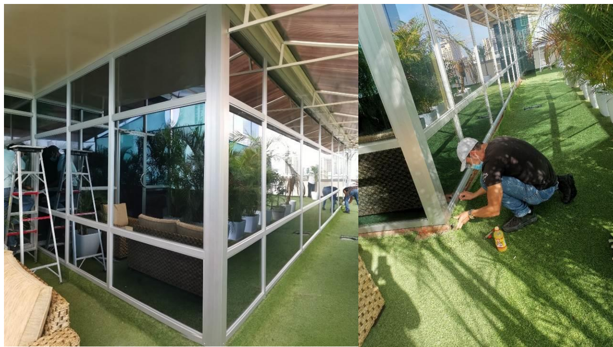
Fotos: Suministro e instalación de vidriera externa en las oficinas del Despacho Superior, Piso N°17 derecho. Efectuada por la empresa Luis Carlos Mora, a un costo de B/5,700.00. Diciembre de 2020.
