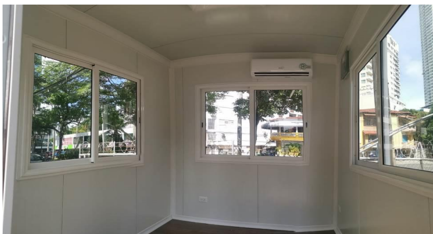
Fotos: Suministro e instalación de caseta de control de vehículos en el estacionamiento de Sarigua. Efectuado por la empresa Isobox, S.A., a un costo de B/8,324.60. Agosto de 2021.
