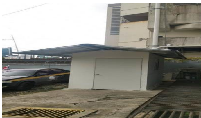
Foto: Suministro e instalación de caseta del lava autos en el estacionamiento de Sarigua. Efectuado por la empresa H & M Building Corp., S.A., a un costo de B/2,295.15. Agosto de 2021.
